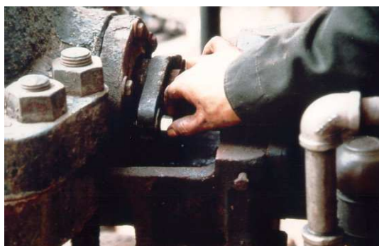
Fot. 9 Montaż dławnicy
