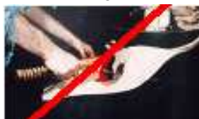
Fot. 5 Redukcja profilu szczeliwa
