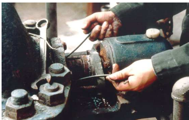
Fot. 2: Usuwanie szczeliwa
