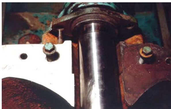
Fot. 4: Kontrola powierzchni wału
